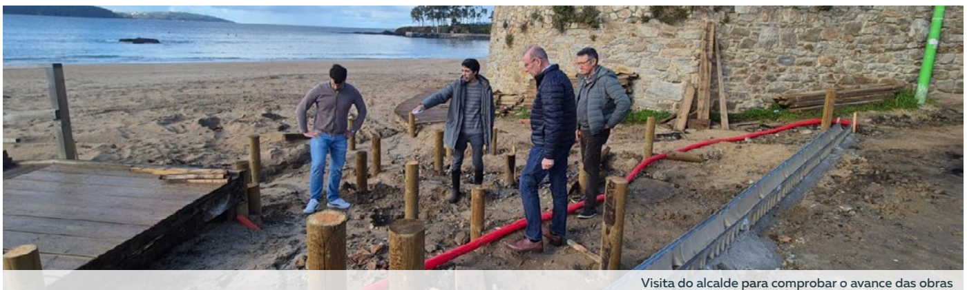
Visita do alcalde para comprobar o avance das obras
