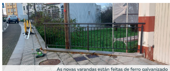
As novas varandas están feitas de ferro galvanizado
